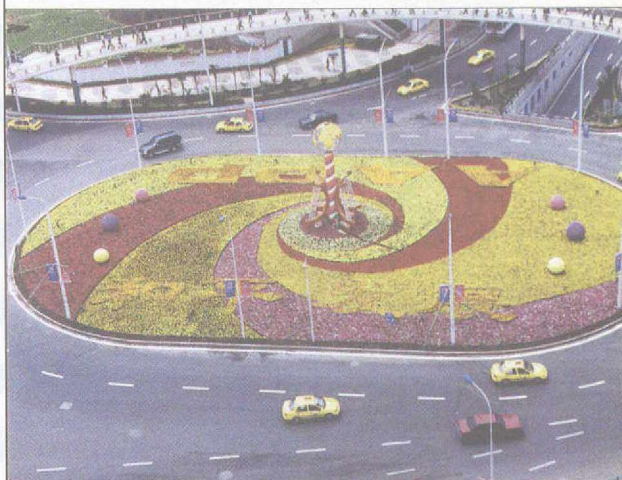
重庆市商业银行支持的重庆上清寺立交桥改造工程
