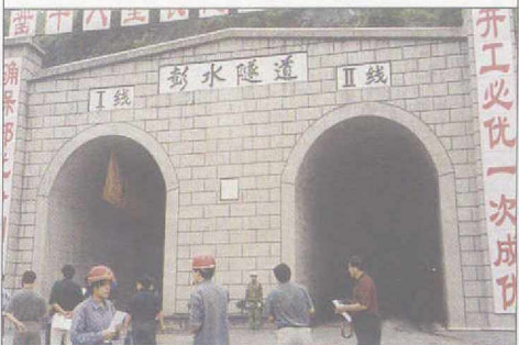
渝怀铁路十一大重点控制性工程之一的彭水隧道(9028米)于2002年10月顺利贯通
